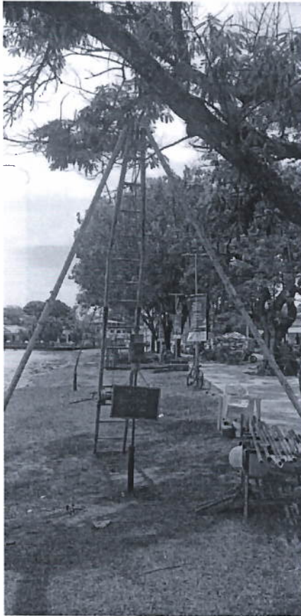
Instalação do furo SP02.
