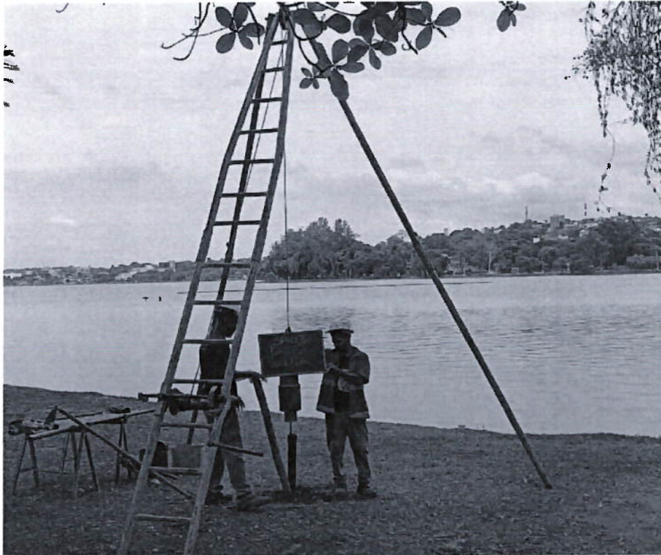
Instalação do furo SP03.
