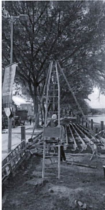
Instalação do furo SP01.
